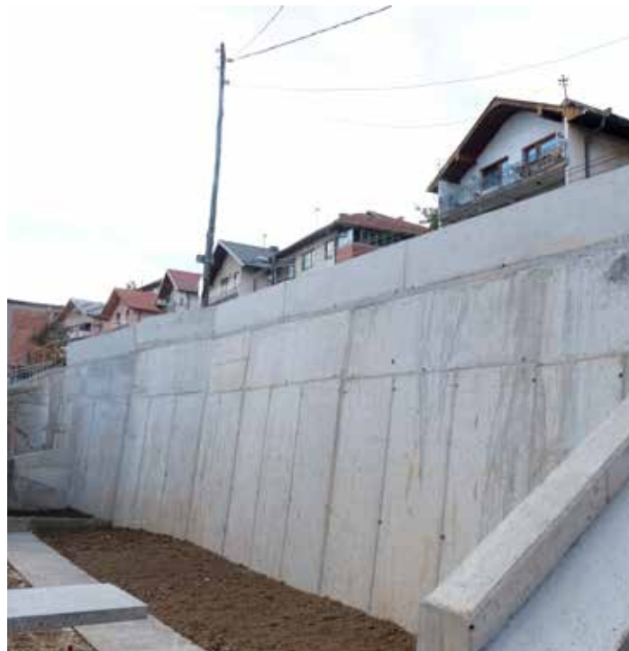
Potporni zid, ulica Asima Čamdžića
