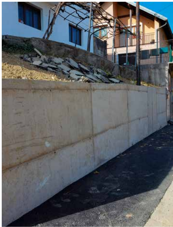
Potporni zid, ulica Kasima Hadžića
