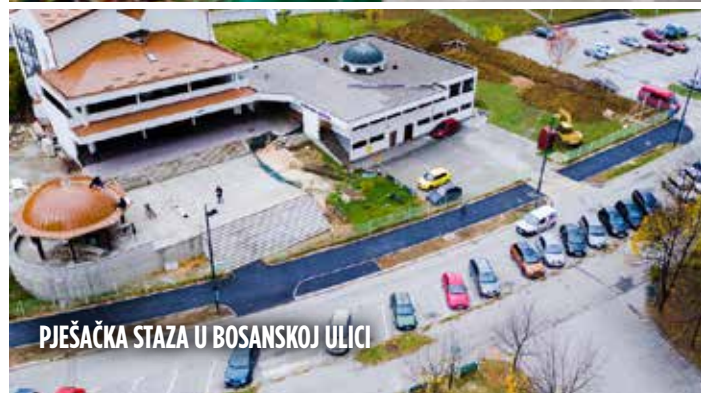
RUHOHVATI STEPENIŠTE U ULICI KASIMA HADŽIĆA
